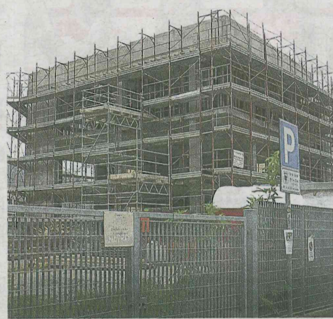
Il cantiere dell'«Edificio 4»: sarà in funzione tra circa 12 mesi
